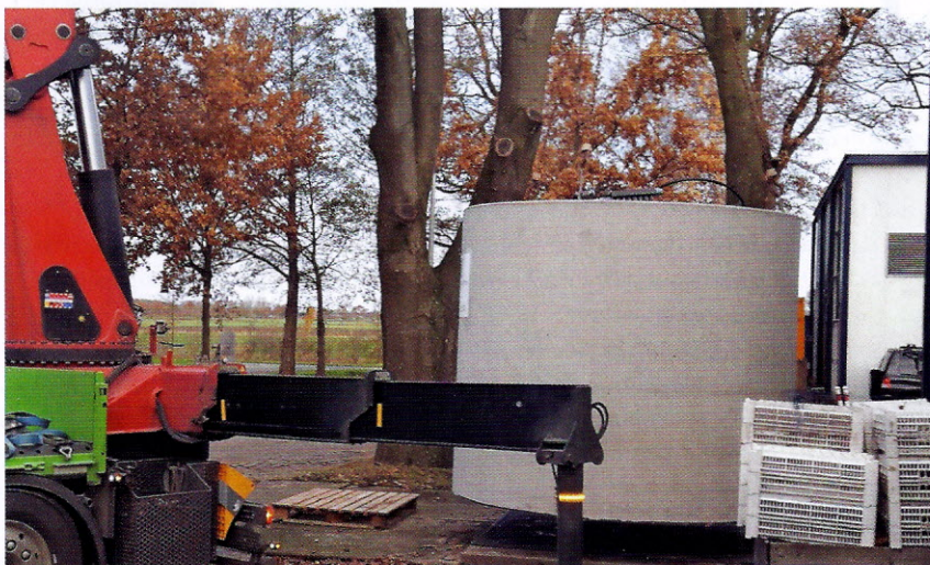
Het ijs wordt in een ijsbuffer opgeslagen en de koude wordt in de herfst gebruikt om de piekvraag naar stroom af te vlakken.
